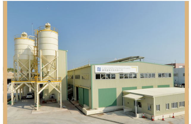
位於香港環保園之嘉華建築材料有限公司生產設施
