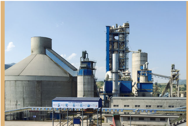
位於雲南省鎮沅縣之普洱昆鋼嘉華水泥建材有限公司水泥廠
